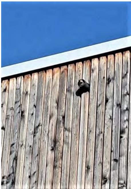
Abb. 14: Revieranzeigendes Haussperlings-Männchen in einem Lüftungsrohr an der Fassade des Kindergartens
