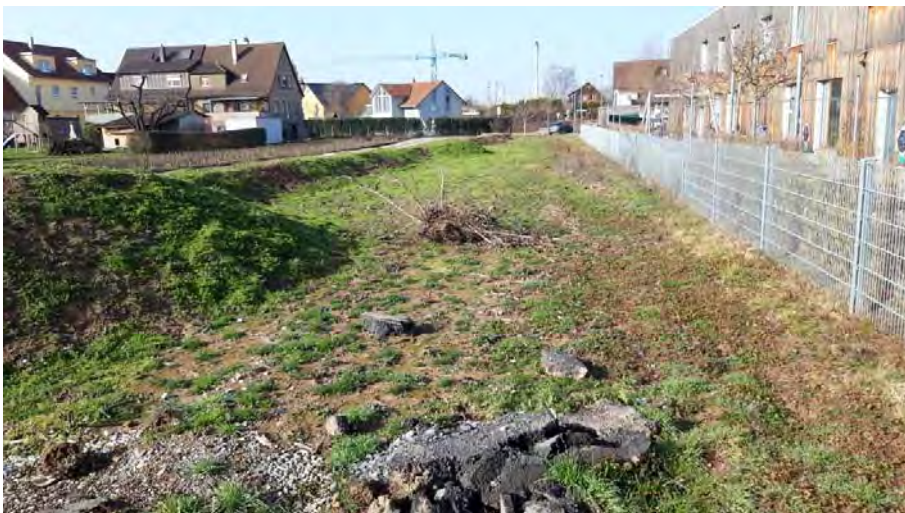
Abb. 9: Die geplante Erweiterungsfläche wird derzeit als Baustraße und Lagerfläche genutzt
