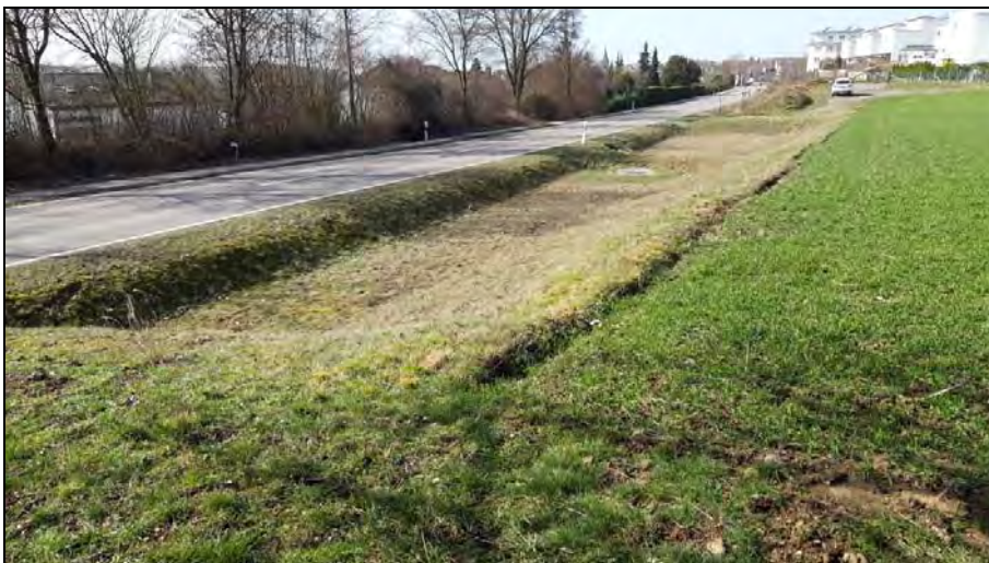
Abb. 5: Retentionsmulde an der „Bietigheimer Straße“
