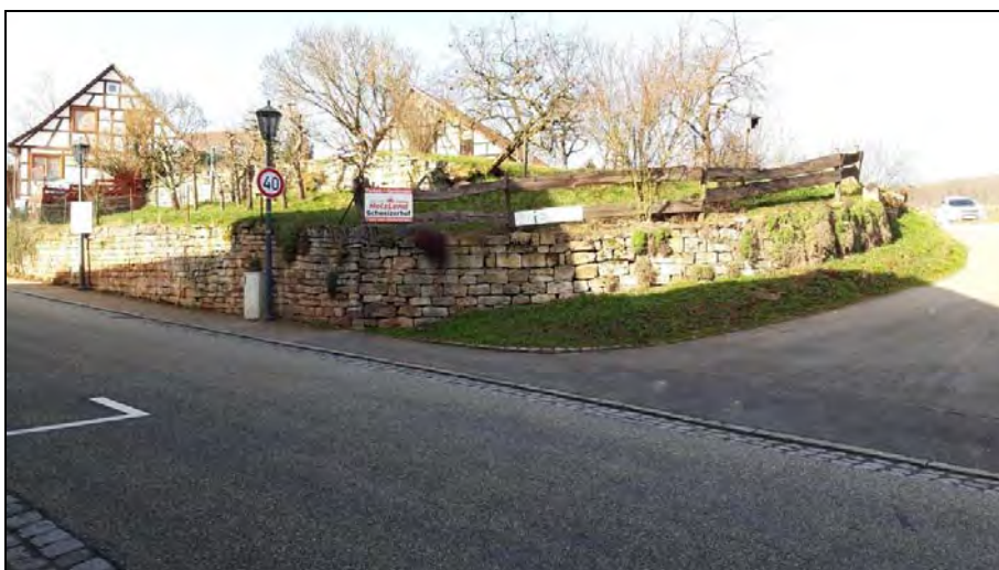
Abb. 11: Trockenmauer entlang der „Dorfstraße“ an der Einmündung zur „Liebenbergstraße“
