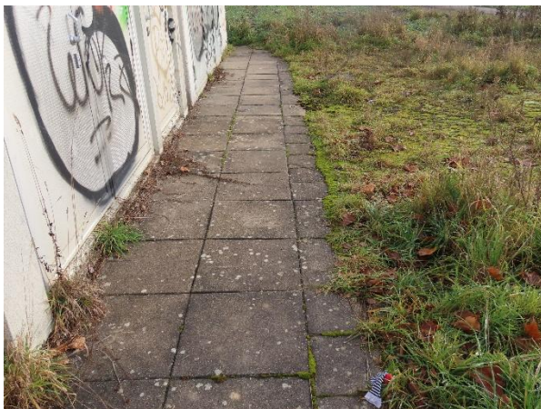
Abb. 12: Verlegte Platten vor Erdgasdruckregelanlage
