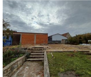
Gebäudeabbrüche und Grundstücksfreilegungen
