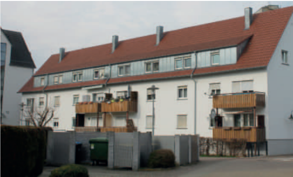
Lange Schleppgaube mit abweichender Materialwahl
