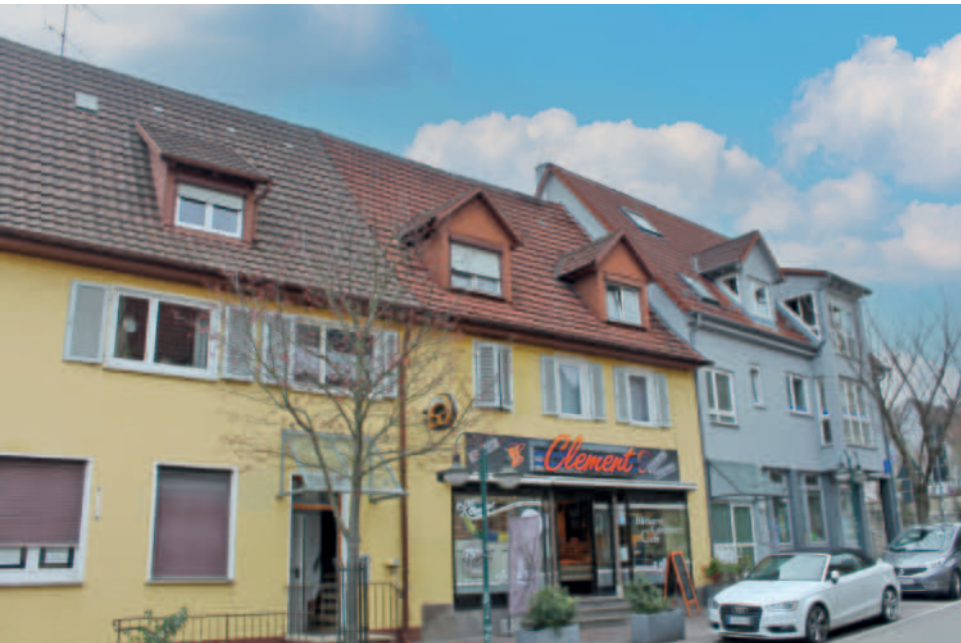
Hauptsächlich Tonziegel als Dacheindeckung
