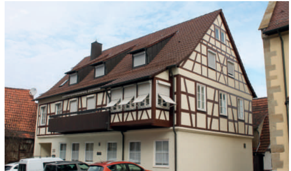
Schleppgauben symetrisch angeordnet angepasst an die Dacheindeckung
