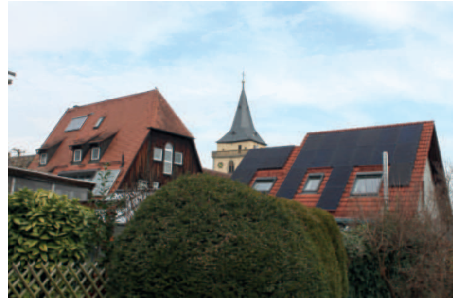
Photovoltaik auf der straßenabgewandten Seite - nicht einsehbar
