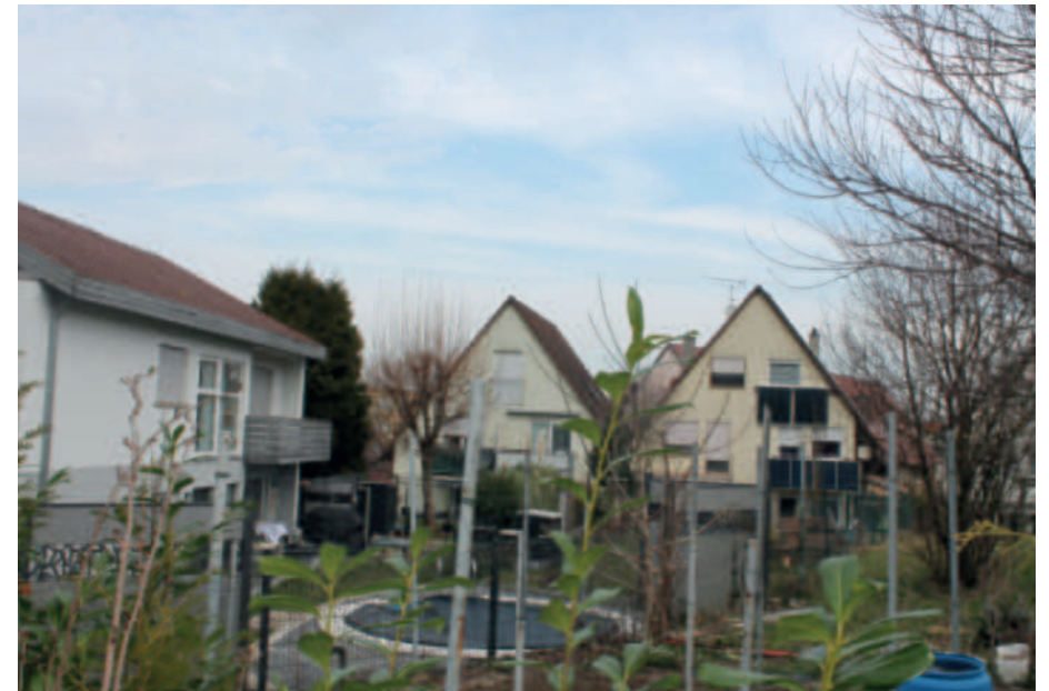
Balkonkraftwerk im rückwertigen Bereich
